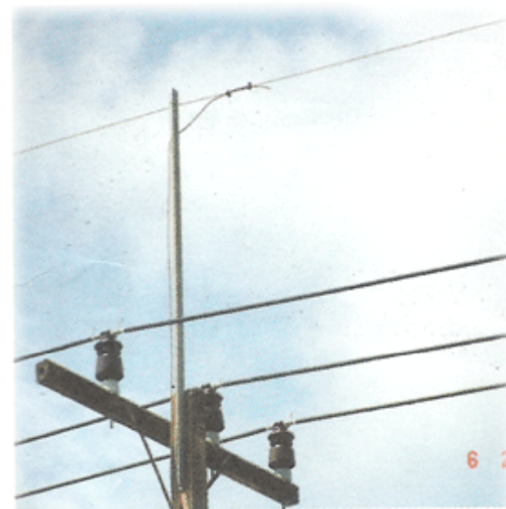
การต่อลงดินของสาย OHGW
