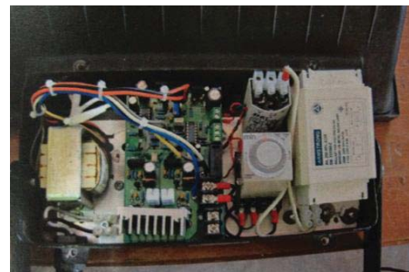
รูปที่ 4 ติดตั้งชุดต้นแบบควบคุมไฟฟ้าแสงสว่าง
